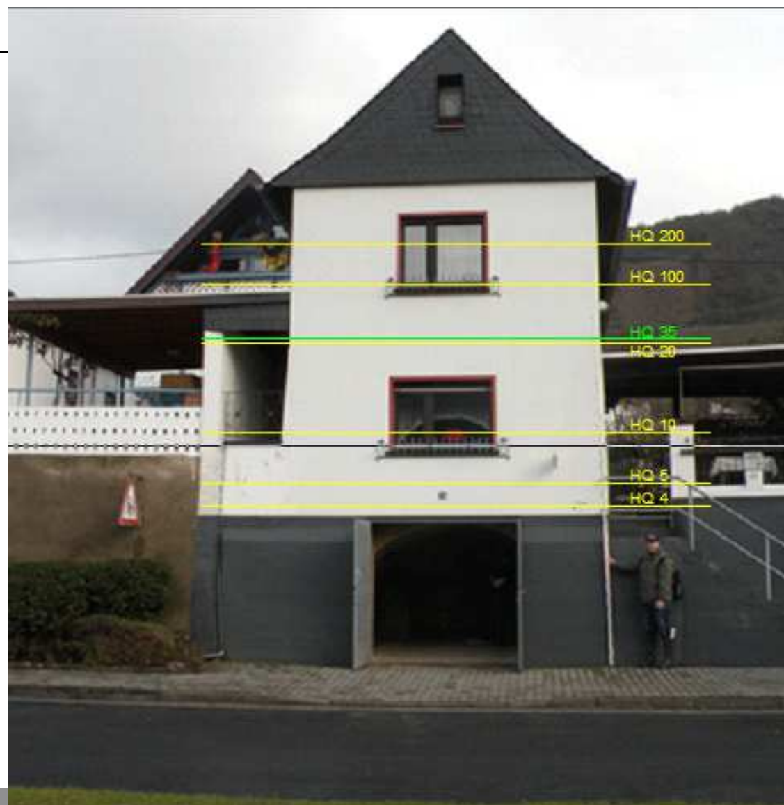
Wohnhaus in Leutesdorf am Mittelrhein mit Darstellung der HW-Gefährdung (Foto: Thul, bearbeitet: Eiden)
